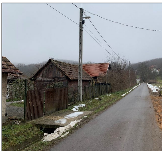
A Szabadság utca déli oldalán kialakított csapadékvízvezető árok
