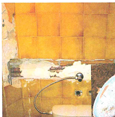
Az elfagyott csövek a falban is hatalmas károkat okozhatnak!
